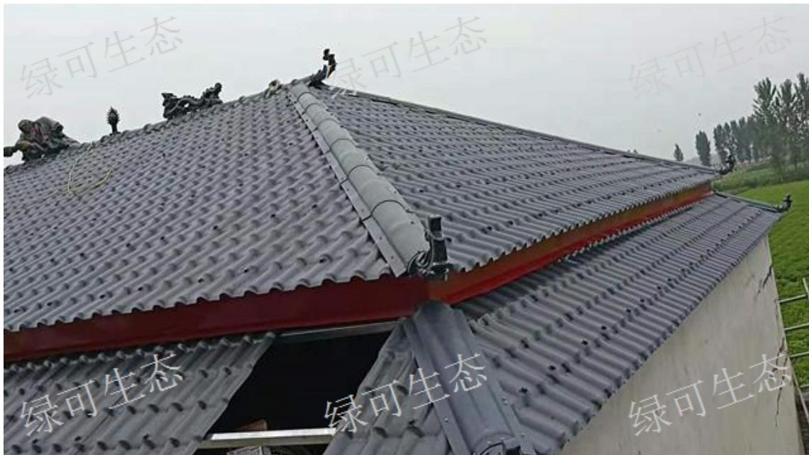
树脂瓦是超耐候性工程树脂ASA和PVC双层共挤成型。以现代工艺技术以仿古型设计构造。主要分为上下两层：上层为抗老化层，由0.2mm厚的ASA树脂材料覆盖合成。下层为抗冲击、耐腐蚀层，由2.8mm厚的PVC化工材料及一些补助材料共挤合成。特点是色彩丰富并经久不褪，轻便耐用，造型美观立体感强且符合我国建筑文化特色，和环保节能的要求。塑钢瓦，主要是以聚氯乙烯树脂（简称PVC）为主要原料，辅以UV抗紫外线剂和其它化工原料，经科学配比，用先进的工艺技术制成，因而具有良好的防火性，防腐性、耐候性，不含石棉成份，颜色鲜艳，环保健康等性能。是彩钢瓦的更新换代的产品。宁夏仿古树脂瓦多少钱一平树脂瓦大概分为天然树脂瓦和合成的树脂瓦。
